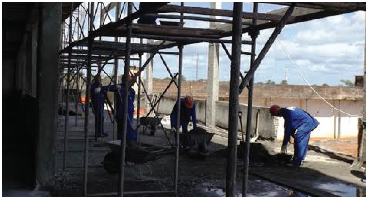
O novo prédio contará com salas de aulas, laboratórios, setor administrativo, banheiros, espaço para convivência e mini-auditório. A obra é fiscalizada pela Secretaria de Infraestrutura
